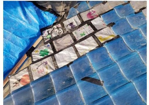
※「アシスト瓦」とは、右の写真のように台風等で壊れてしまった瓦の代わりに応急処置として使用します。状況によっては屋根全体にブルーシートを張るよりも効果的です。
