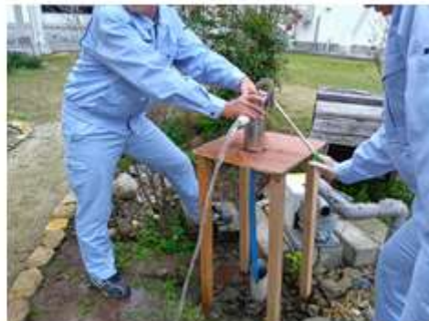
既存の井戸に手動ポンプ設置
