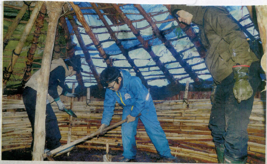
豎穴住居内で内壁の補強に使う土を集める参加者
