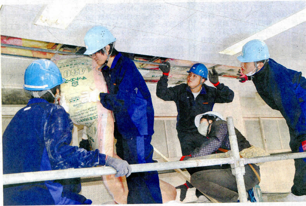
職人らと協力して教室の天井裏に断熱材を施す富士見高校の2年生
